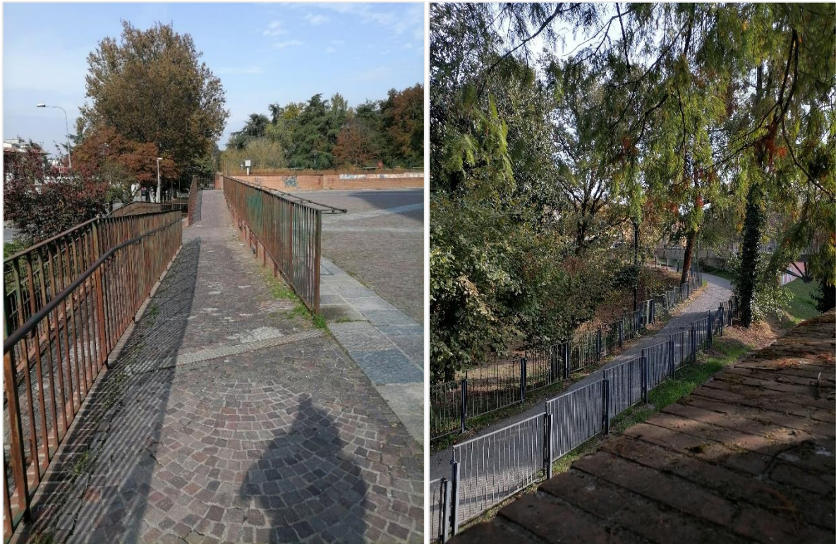
Figura 36 - A sinistra, le rampe tra Viale Dalmazia e Piazza Matteotti. A destra il collegamento pedonale tra il parco e Via del Guasto.
